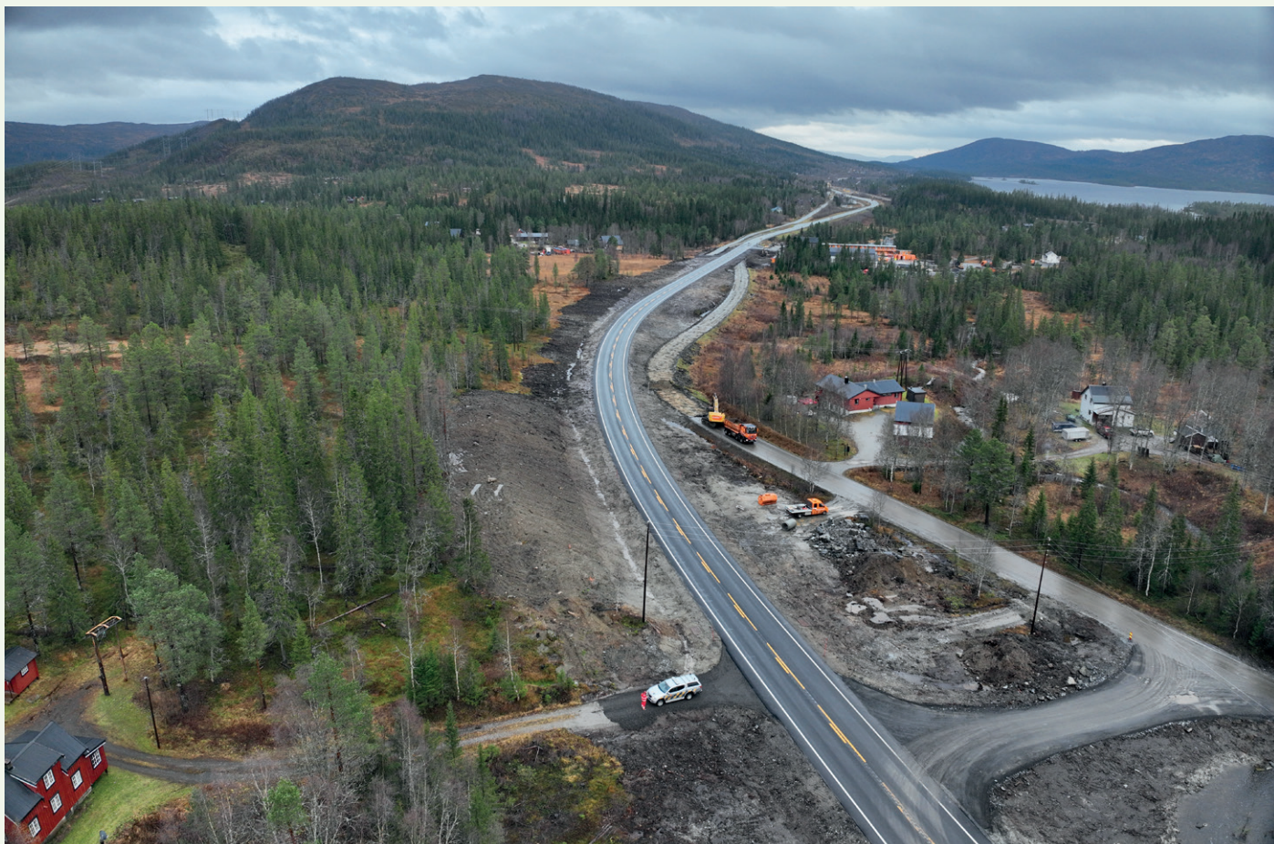
Den nye veien er i stor grad bygget langs eksisterende E6-trase.
