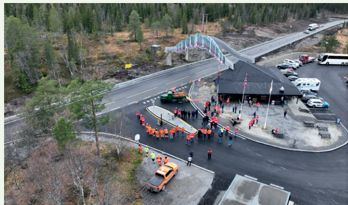
Åpningen fant sted ved landemerket som både går under navnet Nordlandsporten og Porten til Nord-Norge. Foto: Jan-Helge Einan/Statens vegvesen
