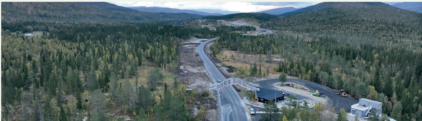
I praksis har prosjektet bestått av to strekninger, Trøndelag grense-Majahaugen og Flyum-Lille Majavatn, på hver sin side av parsellen Johs J. Syltern ferdigstilte for 14 år siden. Foto: Jan-Helge Einan/Statens vegvesen
